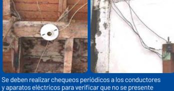
Se deben realizar chequeos periódicos a los conductores y aparatos eléctricos para verificar que no se presente degradación del material que pueda ocasionar pérdida de aislamiento y en el futuro corto circuitos.
